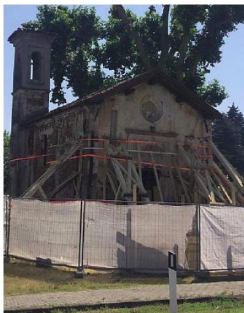
La chiesa San Rocco di Fallaveccia prima dei lavori di restauro
