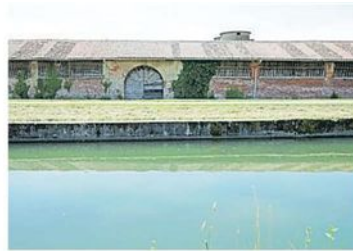
La Cascina Fornace di Santa Cassina e Bissone a Pavia (foto Roberto Oldani)
